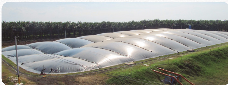
Laguna carpada para captura y almacenamiento de biogás. Foto: archivo Fedepalma.
