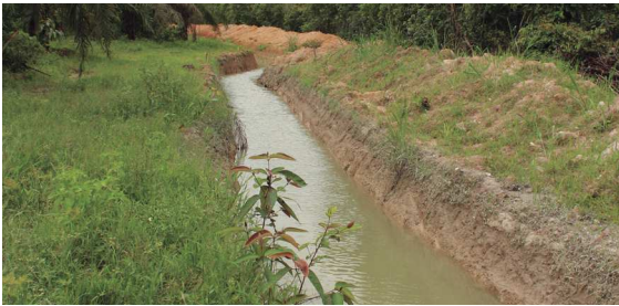
Figura 19. Limpieza y mantenimiento de drenajes.
