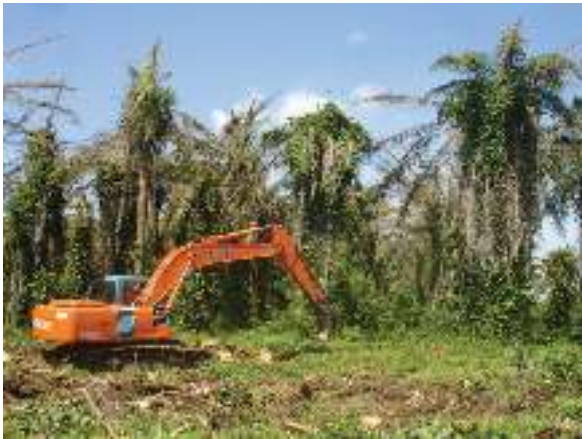
Detalle picado de palmas con excavadora.
