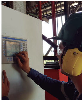
Energizado de equipos
