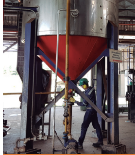
Purga de tanques sedimentadores
