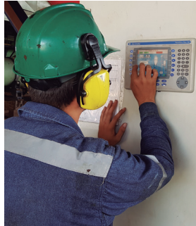
Suspensión de la energía eléctrica
