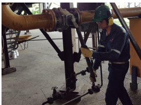
Evacuación de tierras del decantador estático
