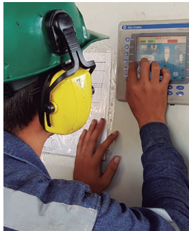
Suspensión del suministro de energía eléctrica
