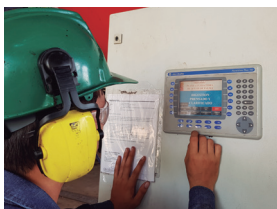
Energizado de equipos
