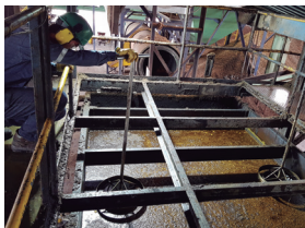
Revisión del estado del preclarificador
